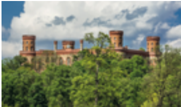
Kamieniec Ząbkowicki Palace
